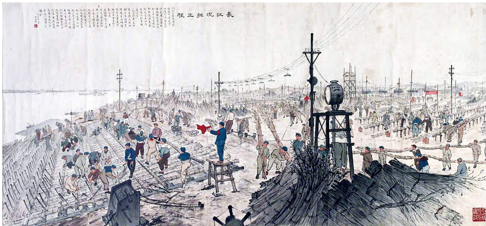
长江沉排工程
