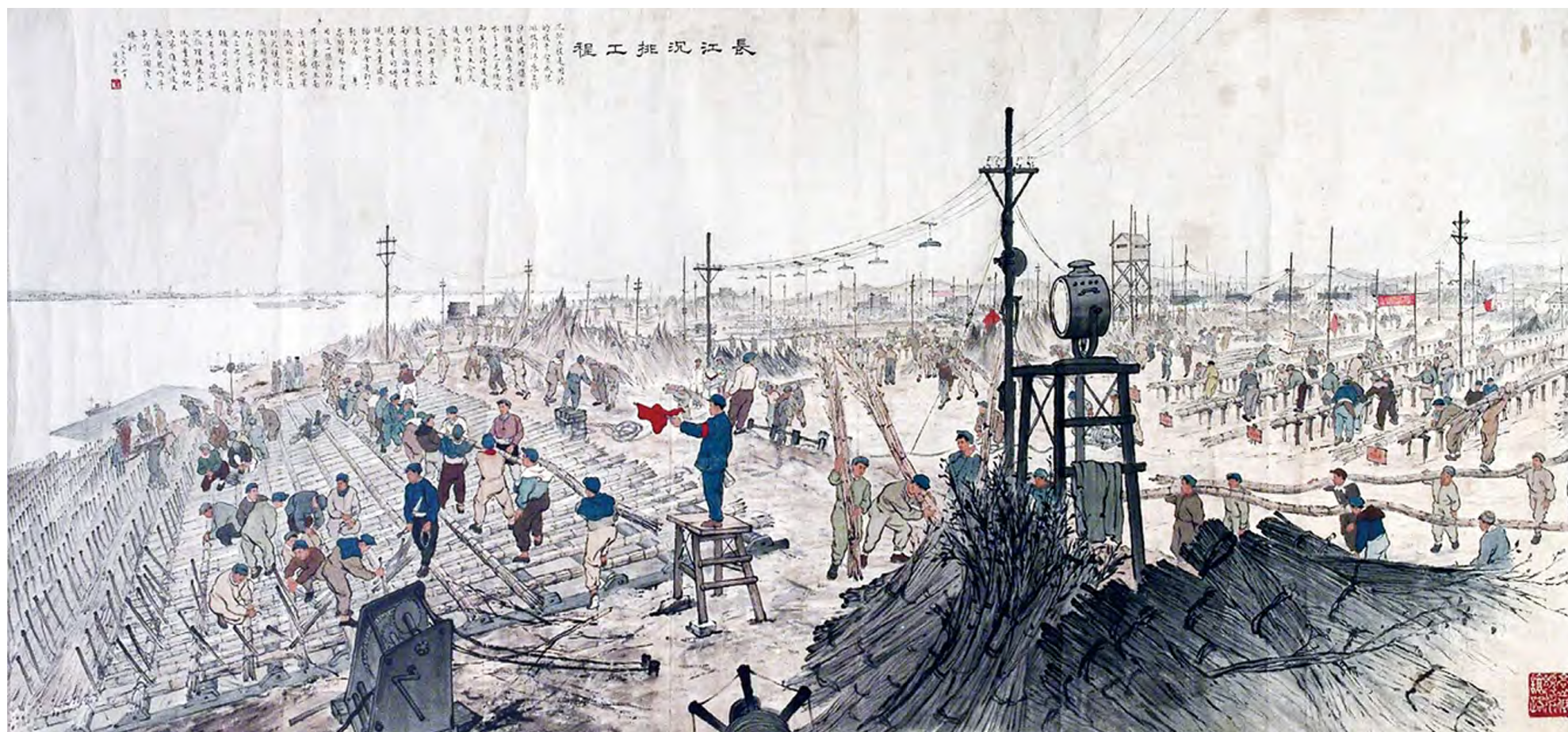
长江沉排工程
